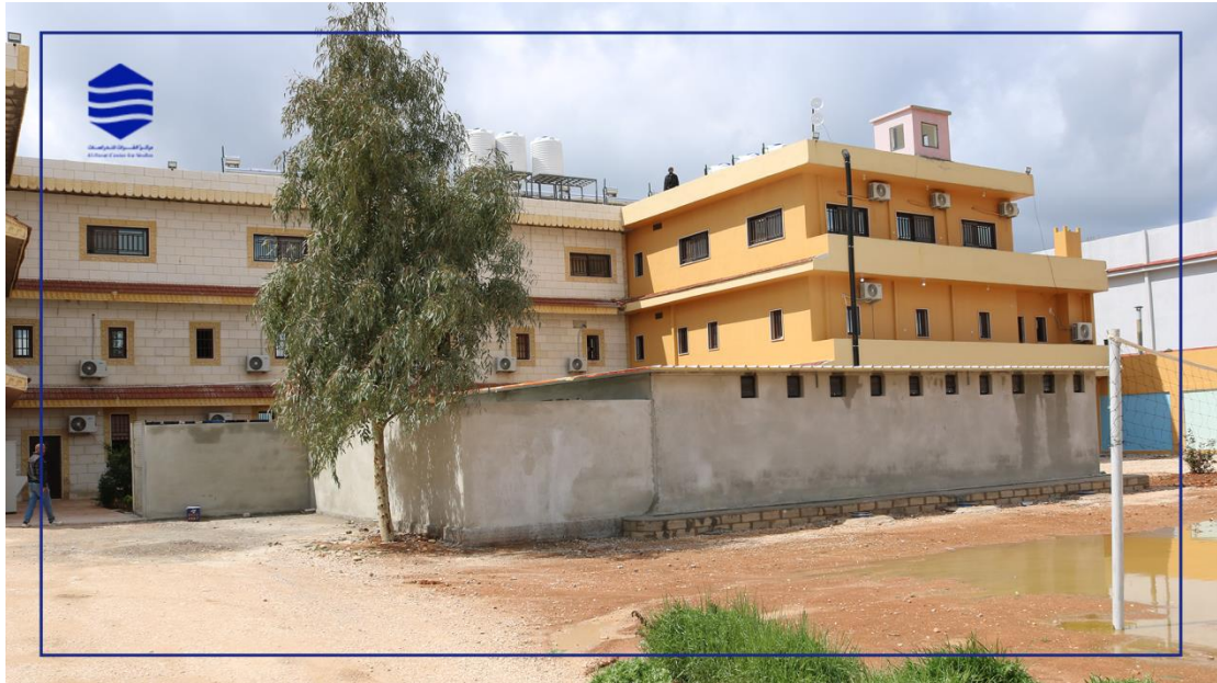
Avahîya navenda Orkêş a rehabilitasyona zarokên DAIŞ`ê
